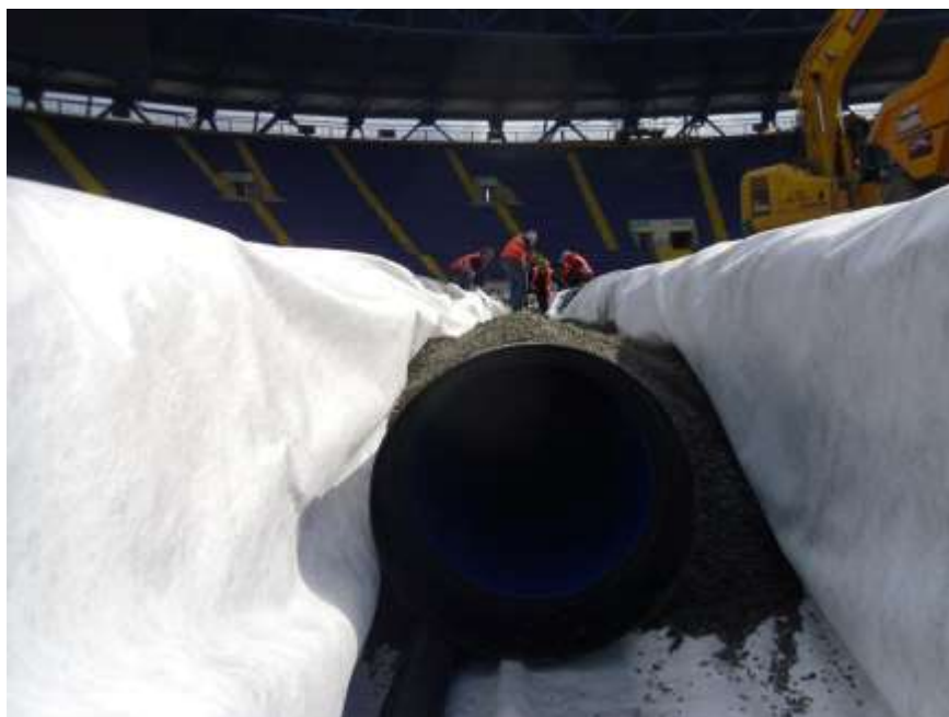
Rys. 8 Systemy odwadniania murawy.
