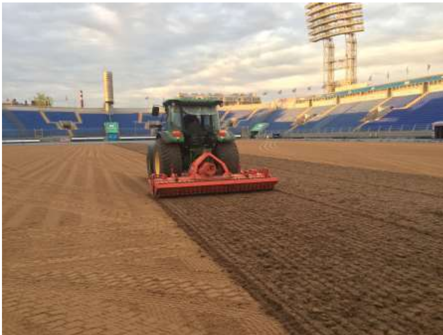
Rys. 15 Montaż wzmocnionej warstwy korzeniowej
