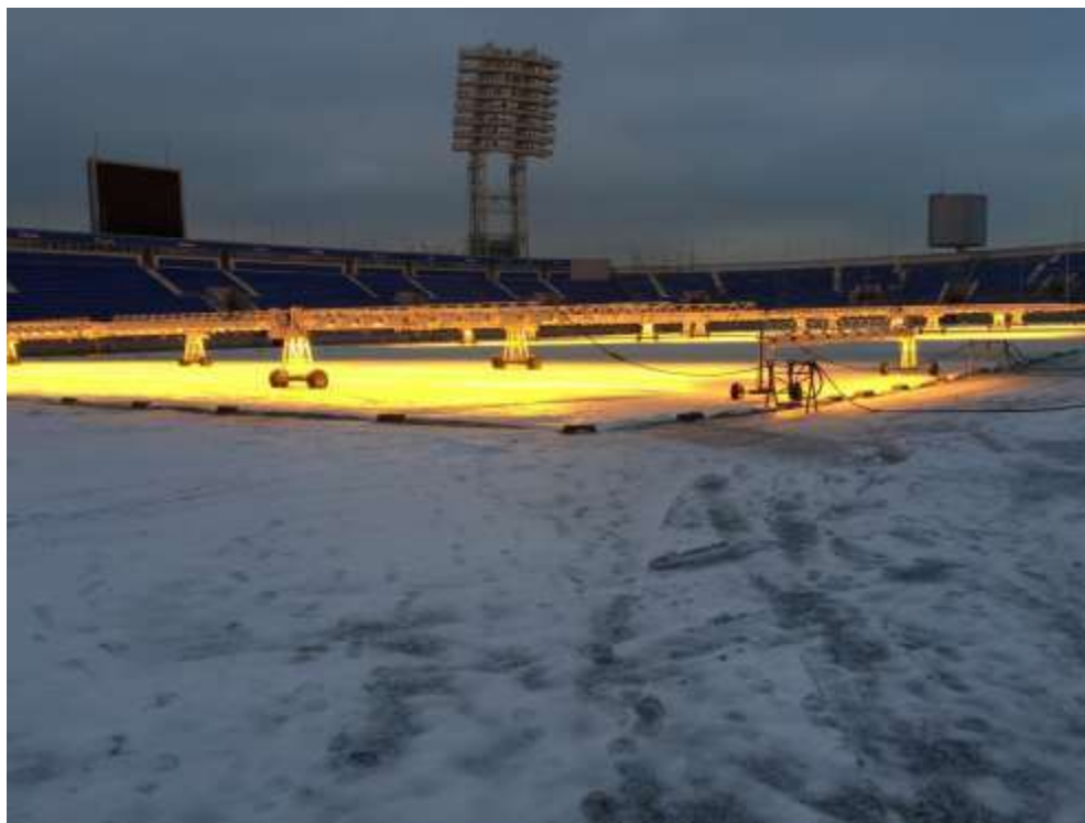
Rys. 27 Osłona przeciwsniegowa i naświetlenie nad osłoną
