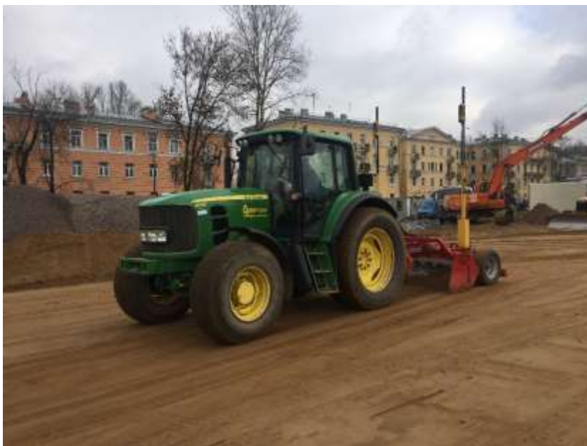
Rys. 13 Niwelacja tolerancji z wykorzystaniem lasera.
