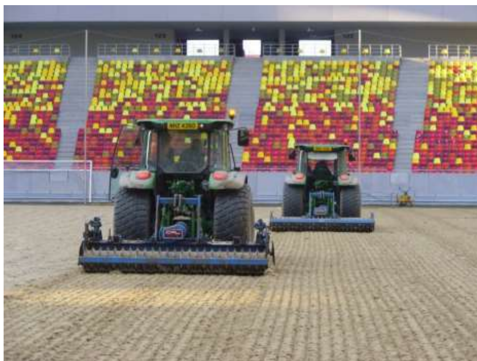
Rys. 51 Przekształcenie murawy w murawę tkaną z włókien.
