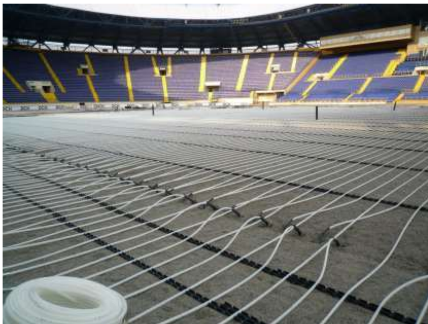
Rys. 10 Montaż podziemnego systemu grzewczego.
