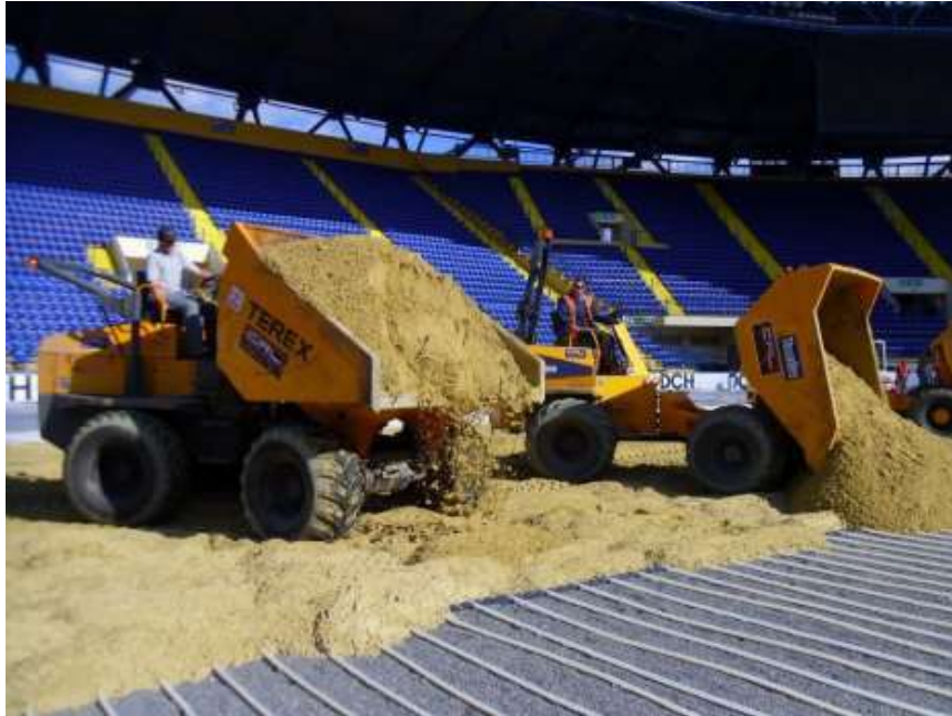
Rys. 2 Użycie właściwego piasku ma kluczowe znaczenie w przygotowywaniu każdej nowej murawy.
