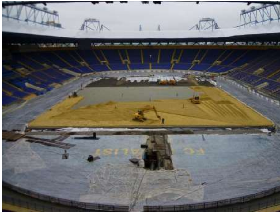
Rys. 7 Kształtowanie spadku murawy zgodnie z kątem nachylenia podłoża.
