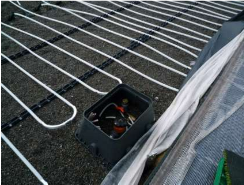
Rys. 9 Montaż modułu sterowania systemem nawadniającym
